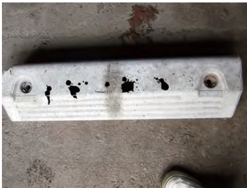
コンクリート製車止め
