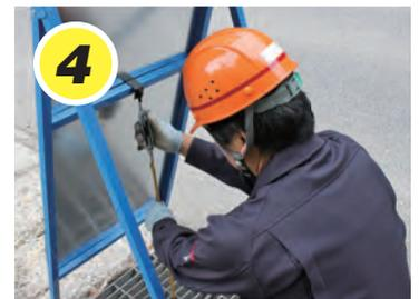
4 ターンバックルを締め、看板をしっかり固定して設置完了です。
