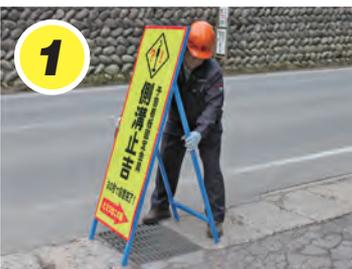
1 グレーチング、またはコンクリート側溝蓋の上に看板を設置します。
