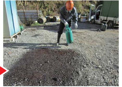
噴射ノズルを開き、スプレーヤー本体が舗装面に平行になるように左右に振りながら乳剤を散布します。
