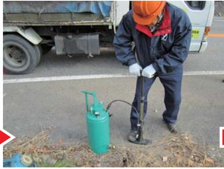
乳剤投入蓋を閉じてボルトをしっかり締め付けた後、付属の空気入れ、又はミニコンプレッサー等で、0.2MPaまで加圧します。
